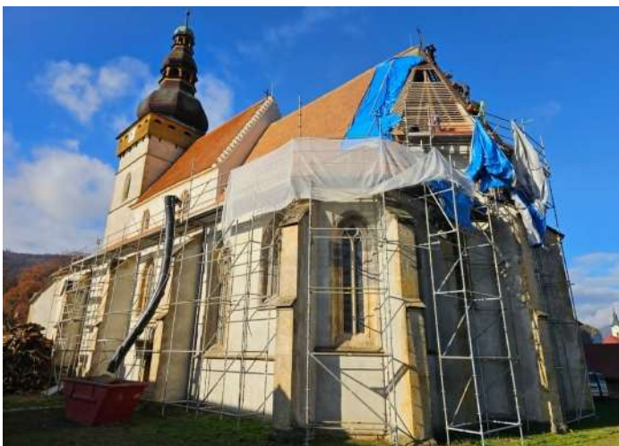
Práce na rekonštrukcii strechy kostola
