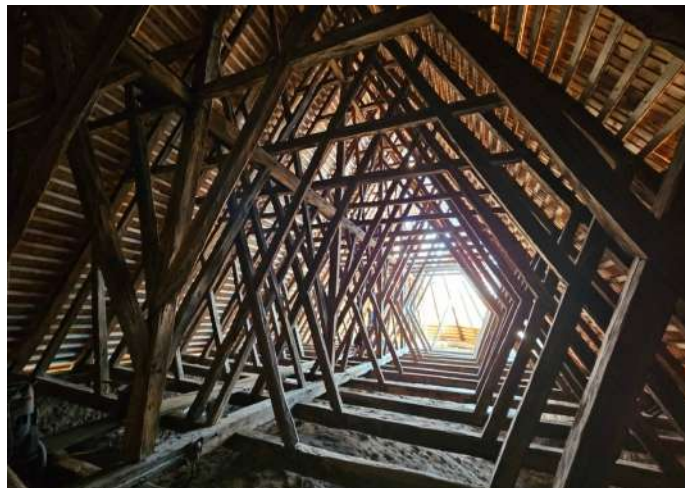
Pohľad do krovu strechy
