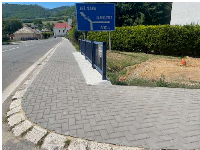
Zrekonštruovaný chodník na Rožňavskej ulici
