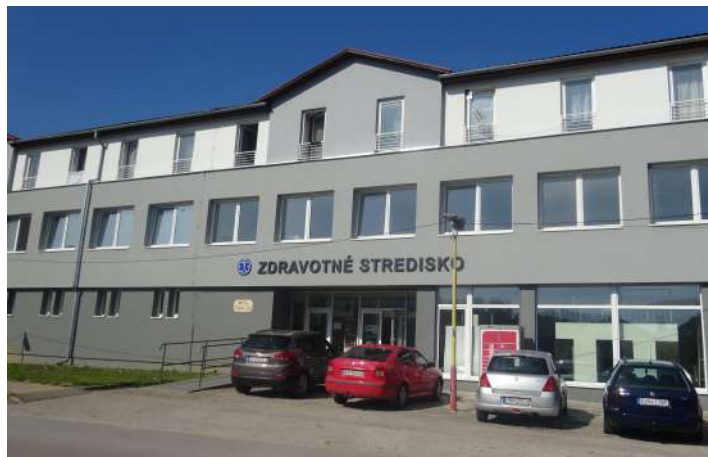
Projekt CIZS - Štítnik, ktorým sa uskutočnila rozsiahla rekonštrukcia zdravotného strediska prebiehal počas rokov 2022 - 2023.
